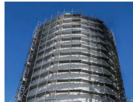
LNGタンクに設置したアルバトロスの円形足場。専用の円形足場用先行手すり、伸縮手すりをを用いることによって全て手すり先行工法で組立解体が可能。
