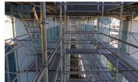
高さ80メートル超のタワーマンション 強化方づえ使用 B2階からの立ち上がり の足場部分は最高高さ約90メートル
