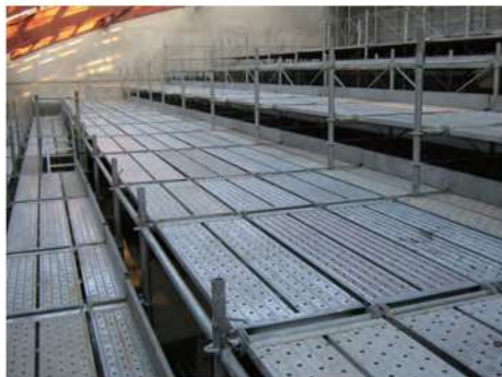
天井の曲面に合わせて縦横状にも設置可能
