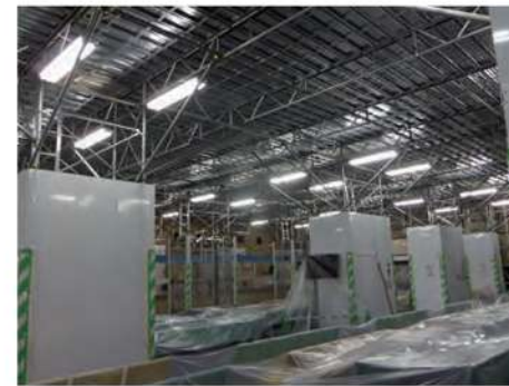
営業しながらホールの天井を改修する工事。支柱4本による柱部分を除けば大きな空間を残すことが可能。工事用のステージの下に養生用の仮天井を設置。
