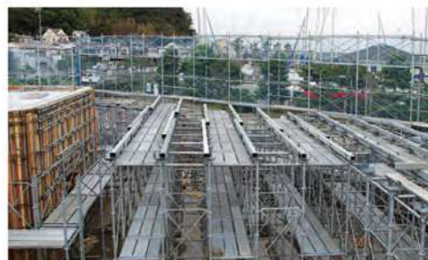
支保工 支保工も手すり先行工法で安全組立て
