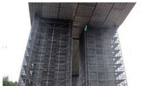
高速道路橋脚 上部工のつりだ足場SKパネルと組み合わせ設置
