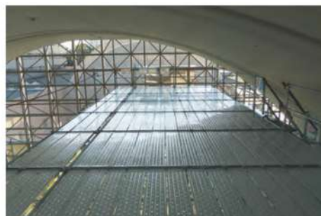
アルバトロスの支柱は連結ピンを取り外すとステージがフラットに。また、支柱プレートを跨いで床付き布わくを敷設できるので、隙間のない設置が可能。 ※写真は組立て作業中
