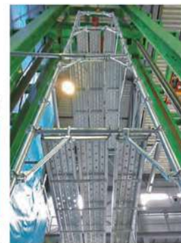
支柱強化の荷重試験
