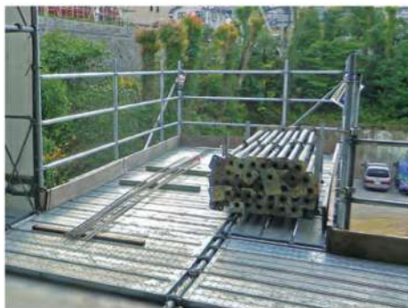
梁枠併用で広い開口確保
