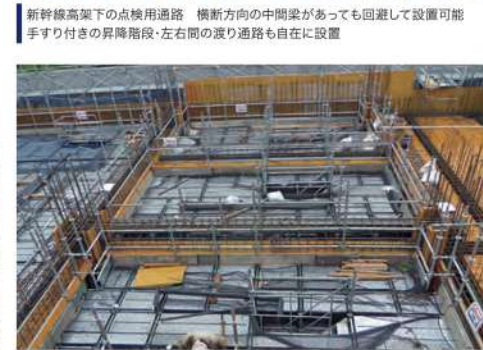
支保工のステージ 作業床は段差なく手すり付き昇降設備も容易 在来型枠支保工と組合せて設置し、存置期間後は設備工事用のステージとしても 無駄なく利用可能
