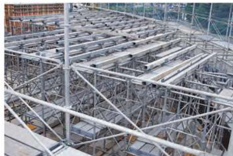
アルバトロスの支保工。くさび式の専用システム支保工と同様にX・Y方向に自由なピッチで割付け可能。 さらに支保工も安全な手すり先行工法で組立・解体が可能。
