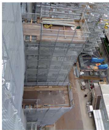
物流倉庫工事にてスラブにレベルを合せて設置したフォークリフト用の荷受構台。敷鉄板敷設。 大引受ジャッキを使用して外周に手すりを簡単に設置することが可能。
