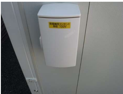
補助用コンセントボックス取付(100V充電用)
