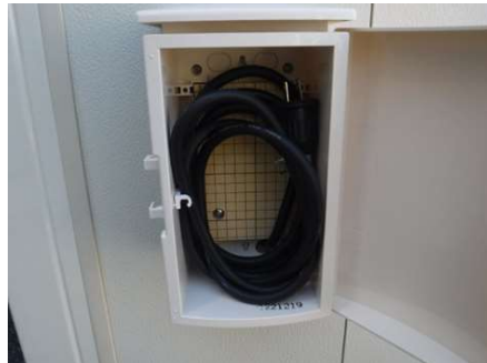
補助用コンセントボックス取付(100V充電用)
